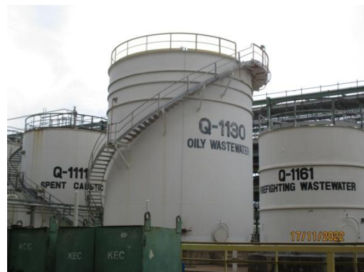
ภาพที่ 3.2-10 Oily Wastewater Holding Tank (Q-1130)
