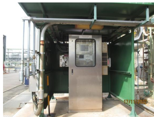
ภาพที่ 3.2-5 อุปกรณ์ตรวจวัดมลพิษอัตโนมัติแบบต่อเนื่อง (CEMs)
