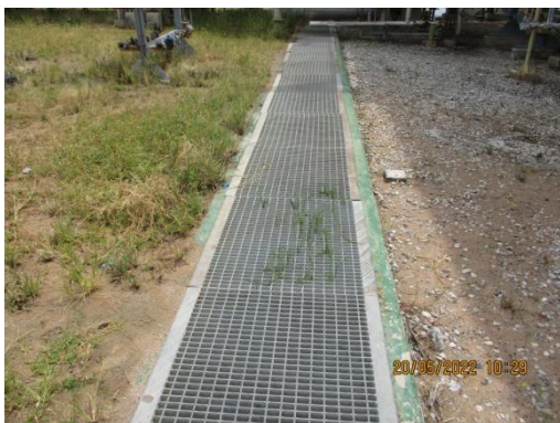
ภาพที่ 3.1-13 การปิดคลุมรางระบายน้ำ
