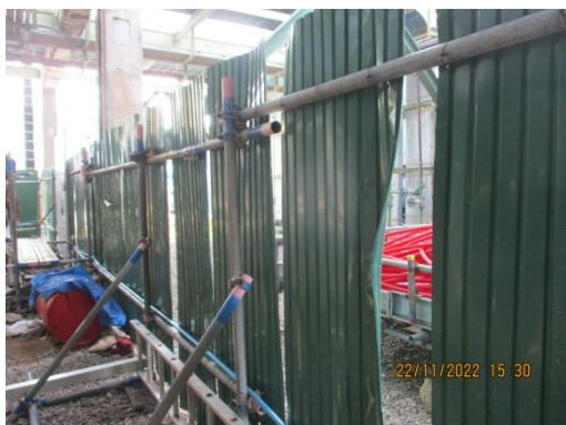
ภาพที่ 3.1-4 การจัดทำรั้วชั่วคราวรอบพื้นที่ก่อสร้าง
