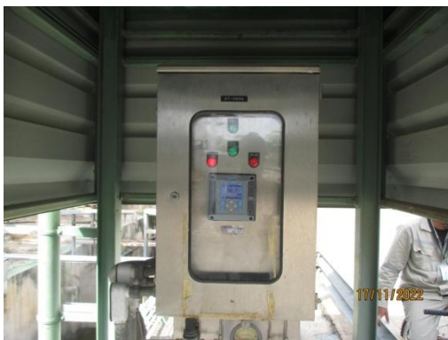
ภาพที่ 3.2-13 ระบบ Online จุดก่อนปล่อยน้ำออกนอกโครงการ
