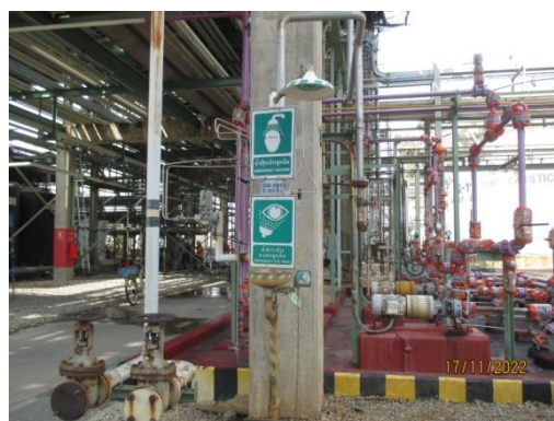
ภาพที่ 3.2-45 ฝักบัวฉุกเฉิน และที่ล้างตา
