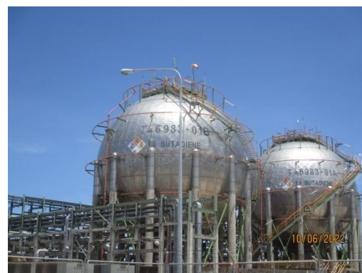
ภาพที่ 3.2-53 ถังเก็บก๊าซ 1,3-บิวทาไดอิน
