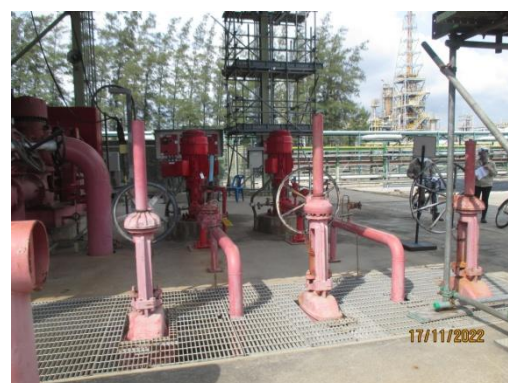
ภาพที่ 3.2-51 แหล่งน้ำสำรองดับเพลิง และเครื่องสูบน้ำดับเพลิง (ต่อ)
