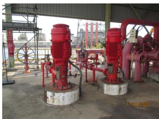
ภาพที่ 3.2-51 แหล่งน้ำสำรองดับเพลิง และเครื่องสูบน้ำดับเพลิง (ต่อ)
