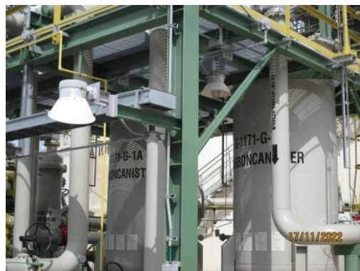
ภาพที่ 3.2-55 ระบบ Activated Carbon Canister
