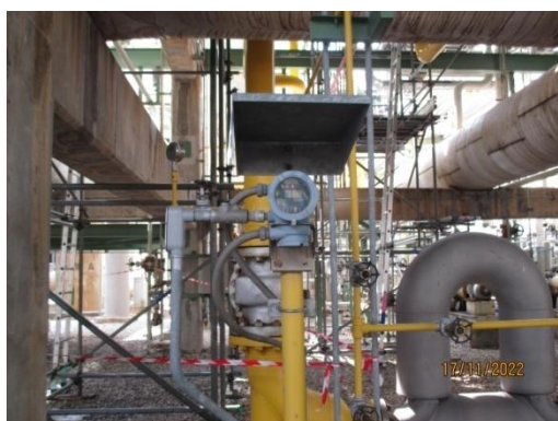
ภาพที่ 3.2-44 Flammable Gas Detector
