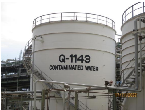
ภาพที่ 3.2-7 Contaminated Water Surge Tank (Q-1143)
