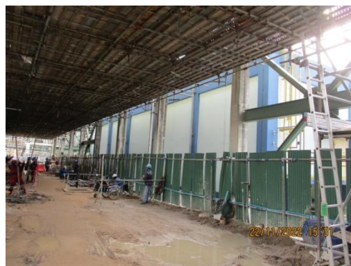
ภาพที่ 3.1-4 การจัดทำรั้วชั่วคราวรอบพื้นที่ก่อสร้าง
